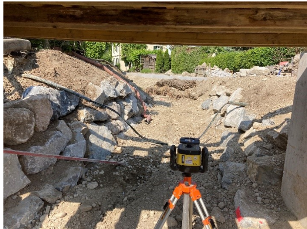
Inhalt: Bachgestaltung Abschnitt Ristrasse Datum: 15.06.2023
