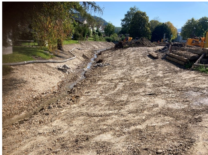
Inhalt: Wasserbauarbeiten Abschnitt 3 Datum: 07.09.2023
