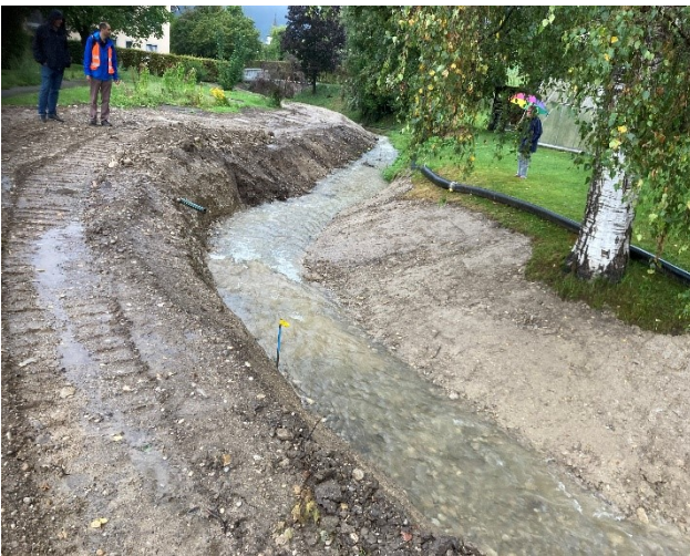
Inhalt: Wasserbauarbeiten Abschnitt 3 Datum: 29.08.2023
