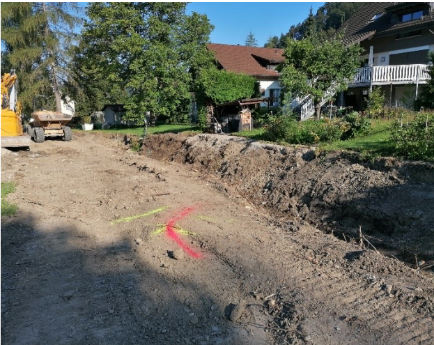
Inhalt: Wasserbauarbeiten Abschnitt 3 Datum: 22.08.2023
