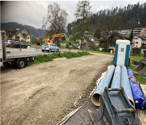
Inhalt: Erstellung Installationsplatz Datum: 18.04.2023
