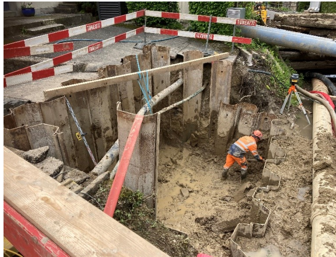
Inhalt: Aushub Brückenwiederlager Datum: 12.05.2023
