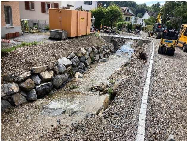
Inhalt: Bachgestaltung Abschnitt Ristrasse Datum: 26.07.2023
