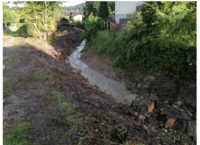
Inhalt: Abschnitt 4 Wasserbauarbeiten Datum: 22.08.2023
