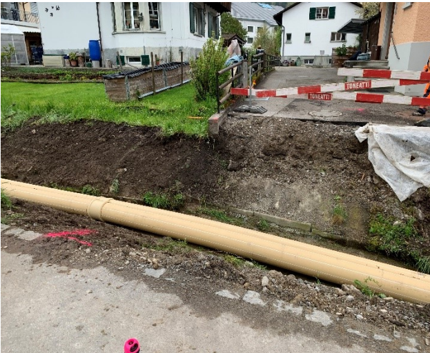
Inhalt: Aushub Brückenwiederlager Datum: 04.05.2023
