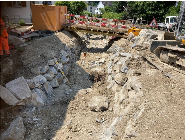
Inhalt: Bachgestaltung Abschnitt Ristrasse Datum: 26.06.2023
