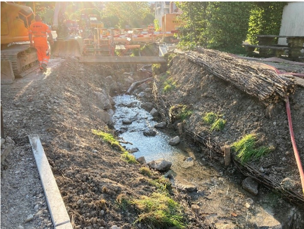
Inhalt: Bachgestaltung Abschnitt Ristrasse Datum: 01.06.2023
